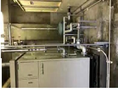
小型ボイラーを設置して各シンクへ給湯する。
