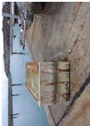
【浮桟橋の状況】（フロートの落下、バンド破損、床面破損等）
