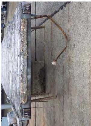
【浮桟橋の状況】（フロートの落下、バンド破損、床面破損等）
