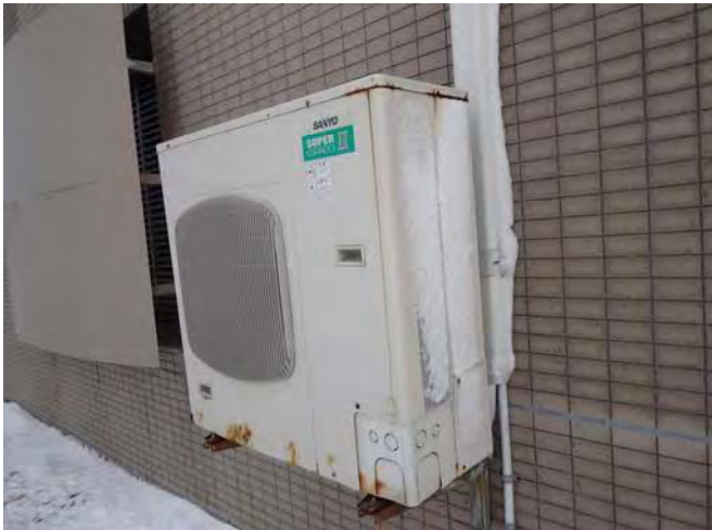
(屋外器現状外観)
