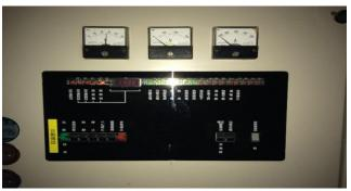
7月5日に電気保安協会による自家用電気工作物月次点検において、非 常用発電機エンジン起動後エラー「H010」(重故障)を表示して非常 経 停止。7月12日に原因調査を行い自動電圧調整器に外観上発錆が見受け られ劣化による自動電圧調整器の不適合が今回の故障要因と判明。
