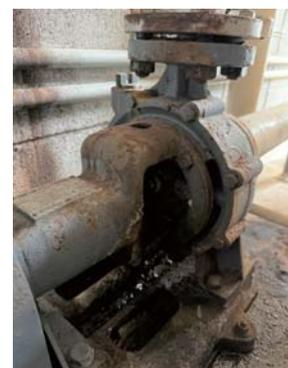
▲経年劣化による腐食が激しく、錆水が発生している
