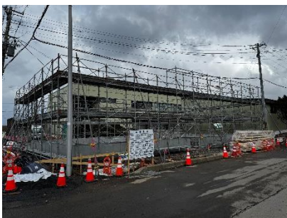
建設が進められている新たな江差町地方卸売市場
