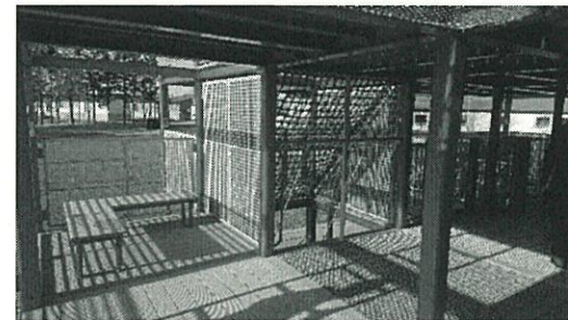
鉄骨造で様々な仕掛けがある
