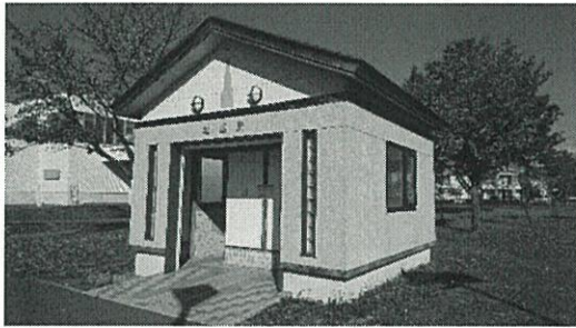
公園内公衆トイレ
